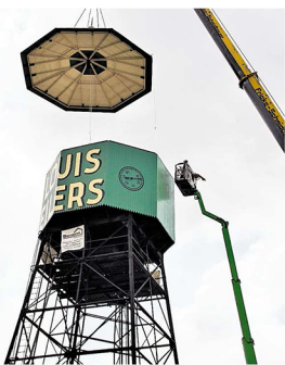
Das Dach des historischen Wasserturms auf dem Eilers-Gelände schwebt ein (Bild 1) und wird von Arbeitern befestigt (*).
